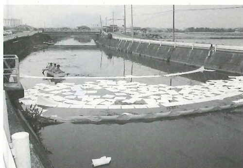
油回収作業の様子
