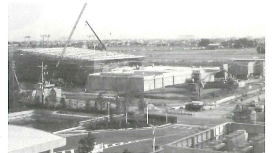
余熱利用施設▶ (建設中)
