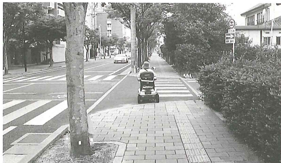
市道江頭藤木線 (バリアフリー整備)
