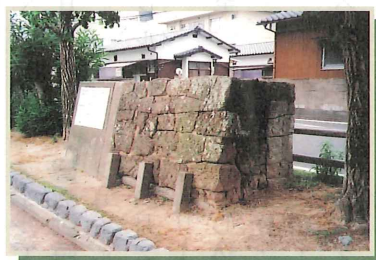
▲移設復元された石垣護岸
