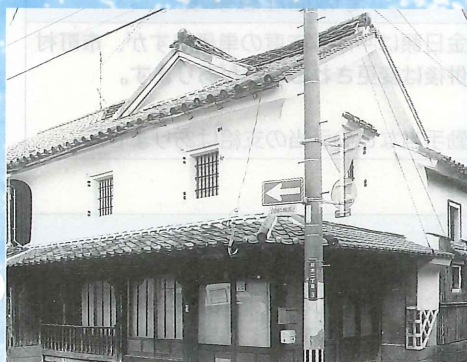
材木町に残る蔵づくりの町屋〈勝木慶造商店〉
