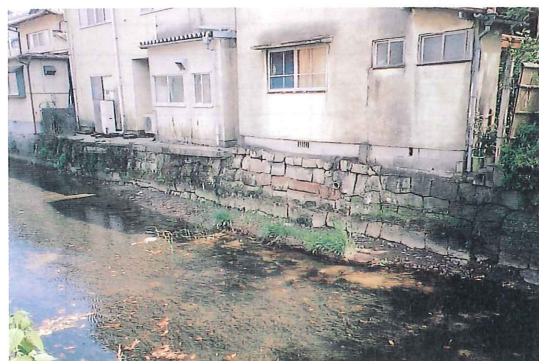
↑布積み技法の石垣〔赤石を使用〕(佐賀県職員互助会館東側付近)
