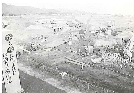
造成が進む久保泉工業団地
