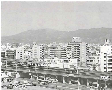
改造を計画しているバスセンター(高架下)
