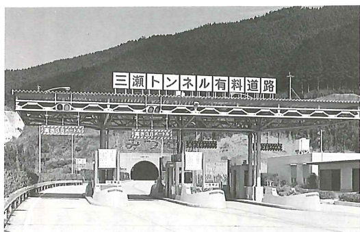
三瀬トンネル
