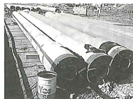
基礎工事円杭
