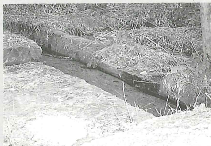
蛤水道に設けられた「のこし」 (手前の一段低いところ)
