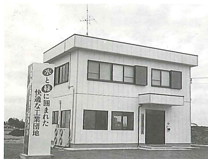
久保泉工業団地工事事務所
