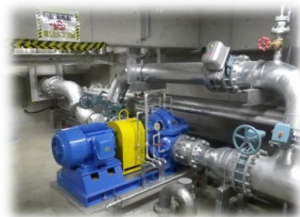
〔写真〕 清掃工場の小水力発電システム
