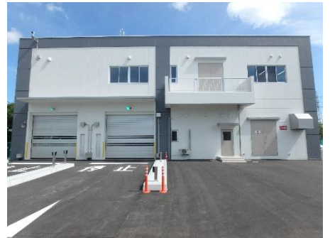
し尿等前処理施設（令和5年7月稼働）
