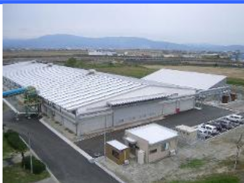
下水汚泥肥料化施設（西与賀）
