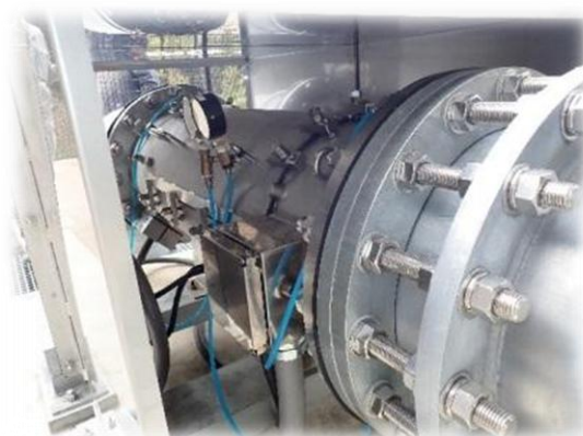
小水力発電機（プロペラ水車）
