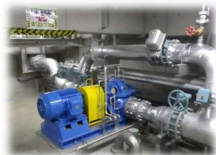
[写真] 清掃工場の小水力発電システム
