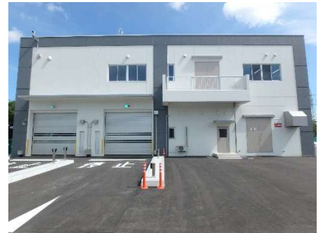
し尿等前処理施設（令和5年7月稼働）
