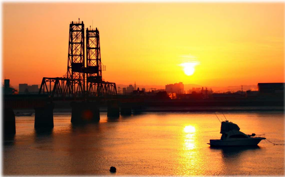
■筑後川昇開橋（諸富町）
