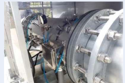
小水力発電機（プロペラ水車）
