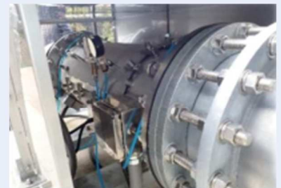
小水力発電機（プロペラ水車）
