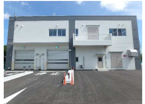
し尿等前処理施設（令和5年7月稼働）
