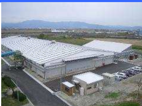
下水汚泥肥料化施設（西与賀）
