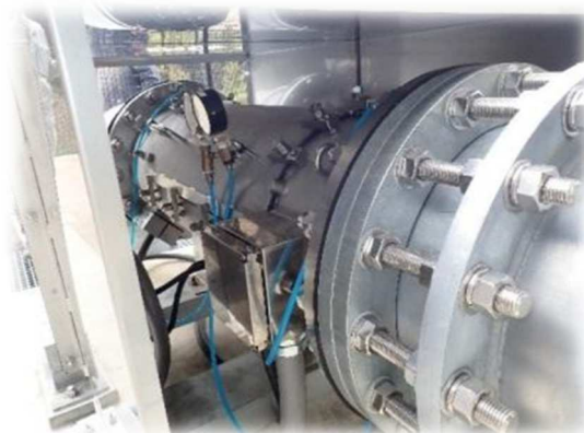
小水力発電機（プロペラ水車）
