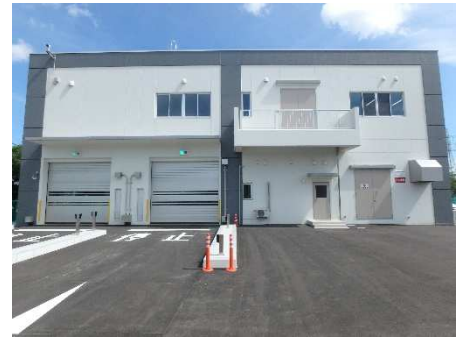
し尿等前処理施設（令和5年7月稼働）
