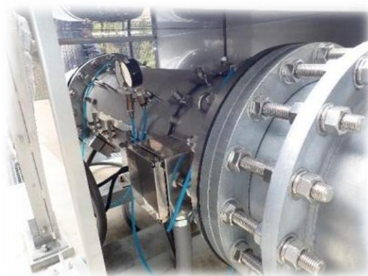
小水力発電機（プロペラ水車）
