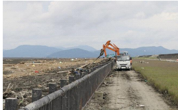
重機による海岸漂着物の回収
