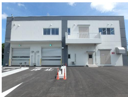
し尿等前処理施設（令和5年7月稼働）
