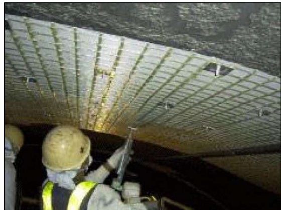
はく落防止対策（ネット工（FRPメッシュ））
