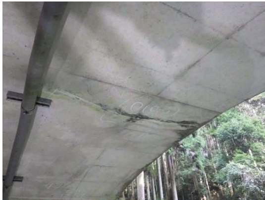
覆工コンクリートの天端のひび割れ (けいのん森の花道)
