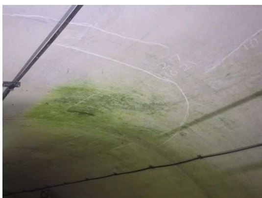
覆工コンクリート天端のひび割れ (畑瀬トンネル)
