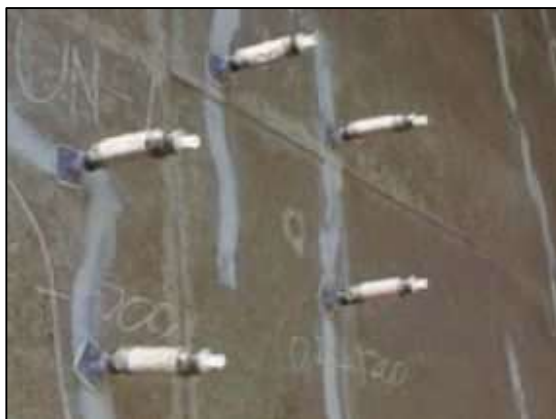
はく落防止対策（ひび割れ注入工）
