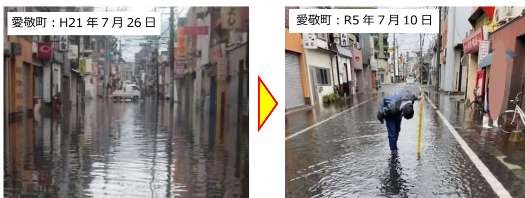
図 2.4.2 対策前と対策後の浸水状況の違い（愛敬町）
