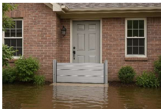
図 3.5.8 建物の浸水対策（止水板）のイメージ
