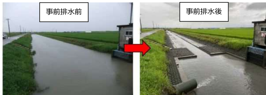
図 3.4.7 農業用排水路等での事前排水
