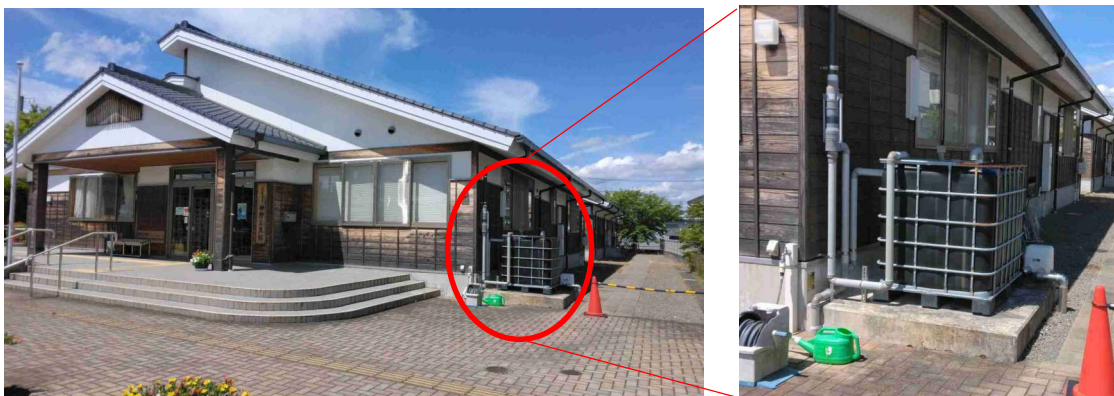
図 3.5.6 雨水貯留タンクの設置（実施例）
