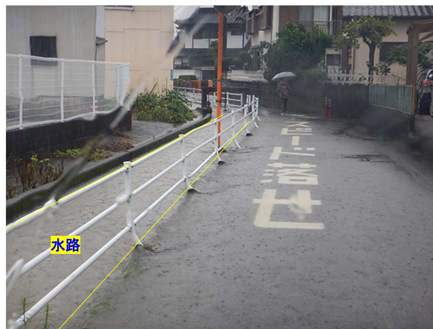
水路水位上昇状況
