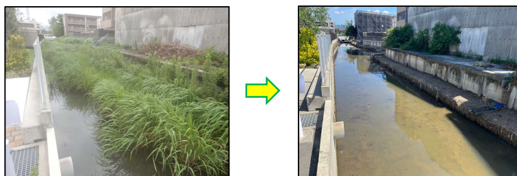
図 3.5.5 水路の水草除去（実施例）
