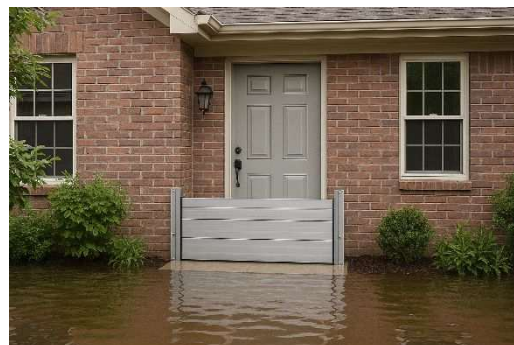
図 3.5.8 建物の浸水対策（止水板）のイメージ
