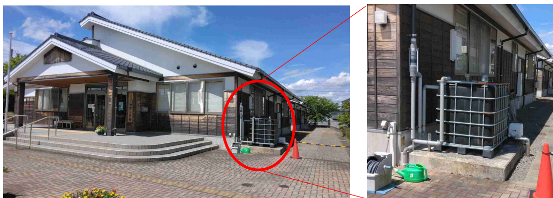
図 3.5.6 雨水貯留タンクの設置（実施例）
