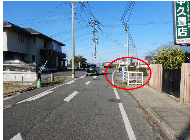
終点側 (歩道未整備区間)
