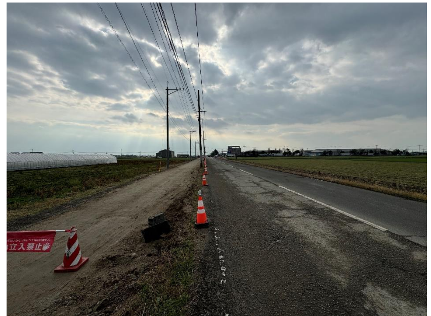
⑦ 道路改良工（拡幅工事中）
