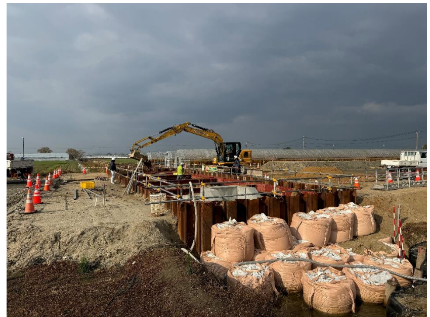
④ 8号函渠（工事中）
