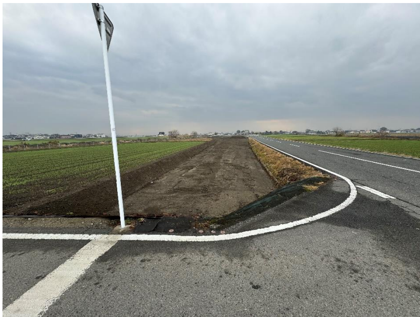
①バイパス区間整備中（先行盛土前）
