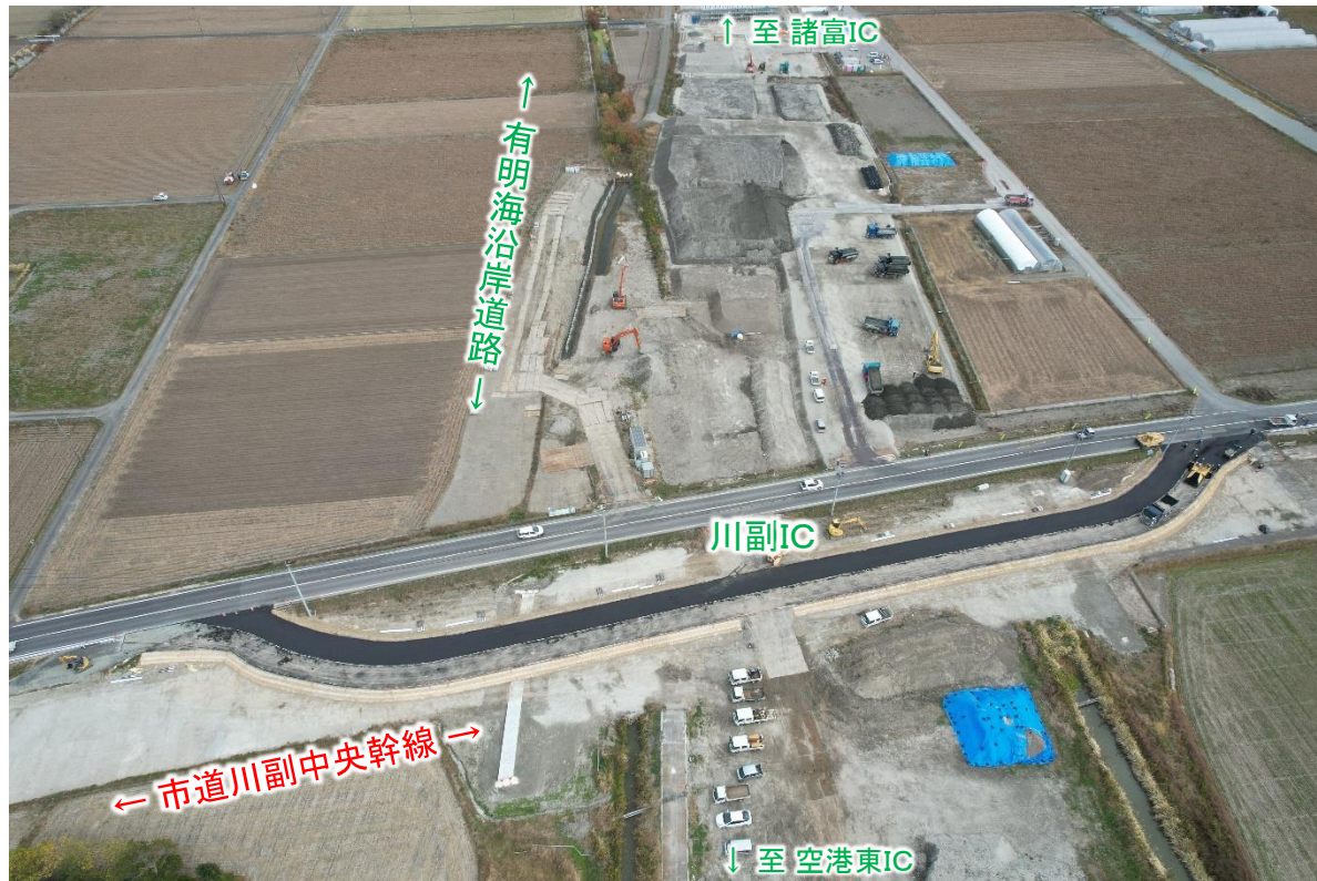
⑤川副IC（工事中）※空撮
