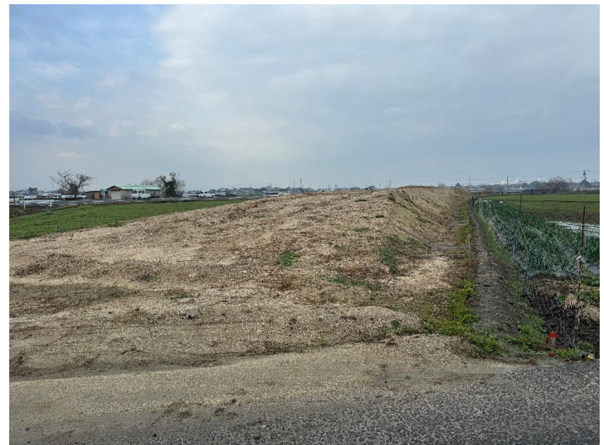
②バイパス区間先行盛土
