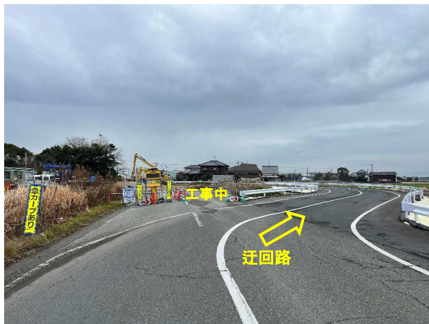
③ 10号函渠迂回路 (工事中)
