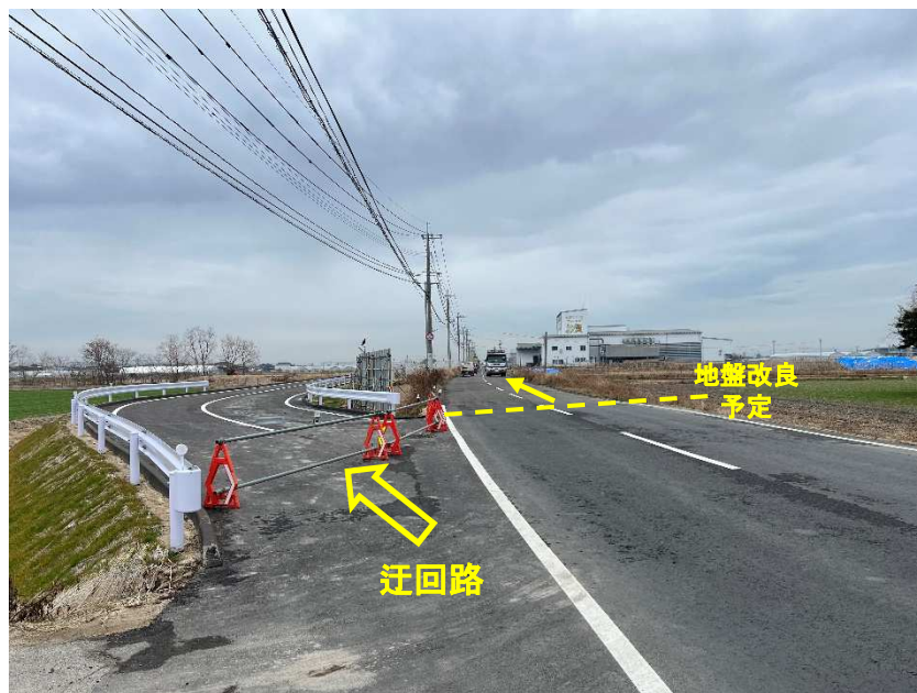
⑤迂回路（工事中）
