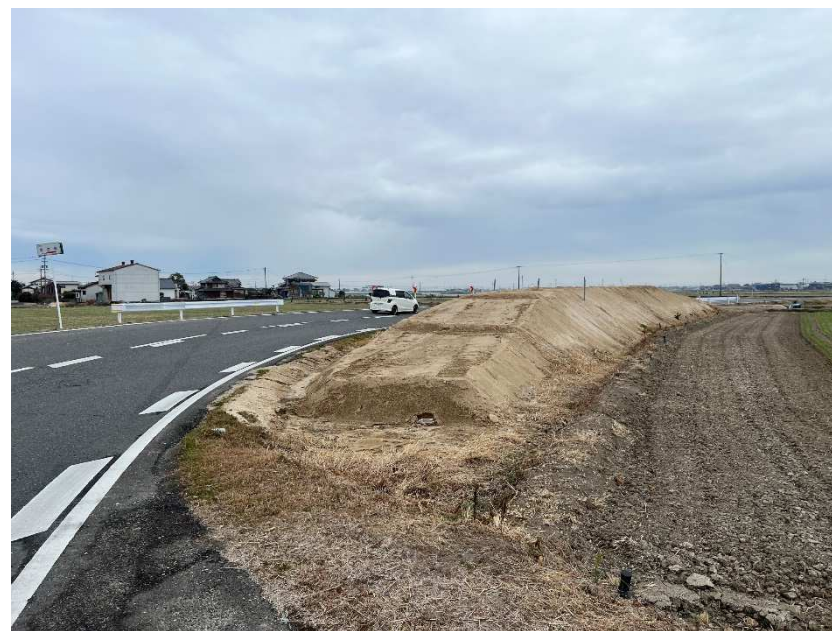
② バイパス区間先行盛土
