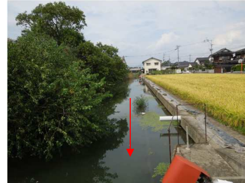
東橋から上流を見る
