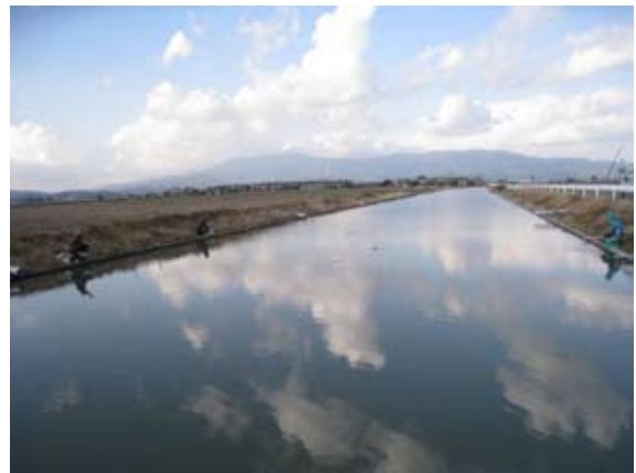
古くから干拓地の農業を支え、現在も利用されている八筋堀の水路（久保田町）
