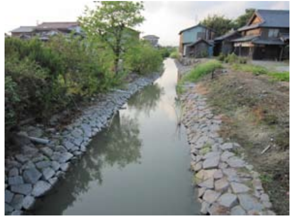
生態系に配慮し自然石で護岸整備されたクリーク・水路（巨勢町）
