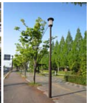
国道263号 (歩道・自転車道)
