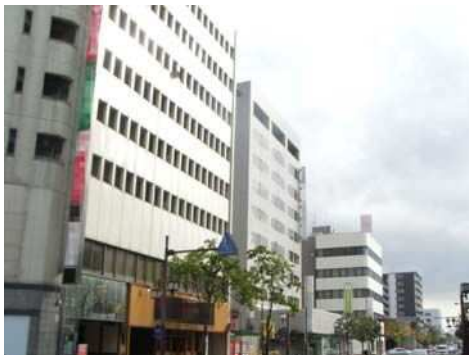
周辺の建築物と同一の色彩を用いた例 （まちゾーン）
