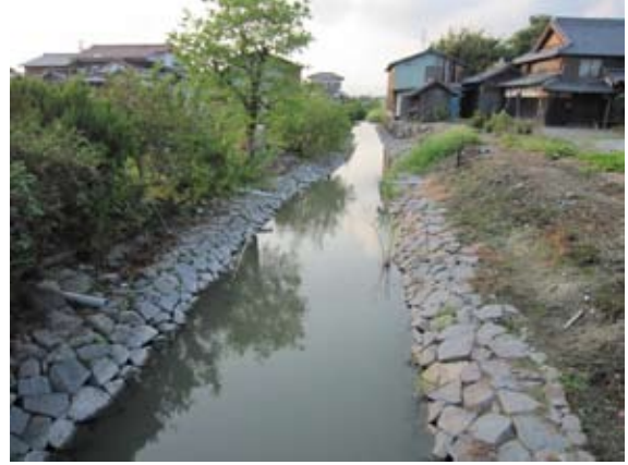
生態系に配慮し自然石で護岸整備されたクリーク・水路（巨勢町）
