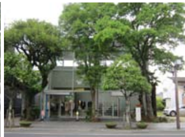
セットバックや緑化等により安らぎとゆとりを演出する店舗
