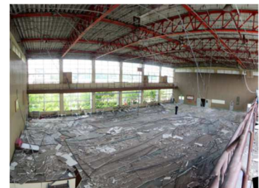
図 天井の崩落 出典：国土交通省国土技術政策総合研究所資料
