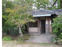
隔林亭前のトイレ
