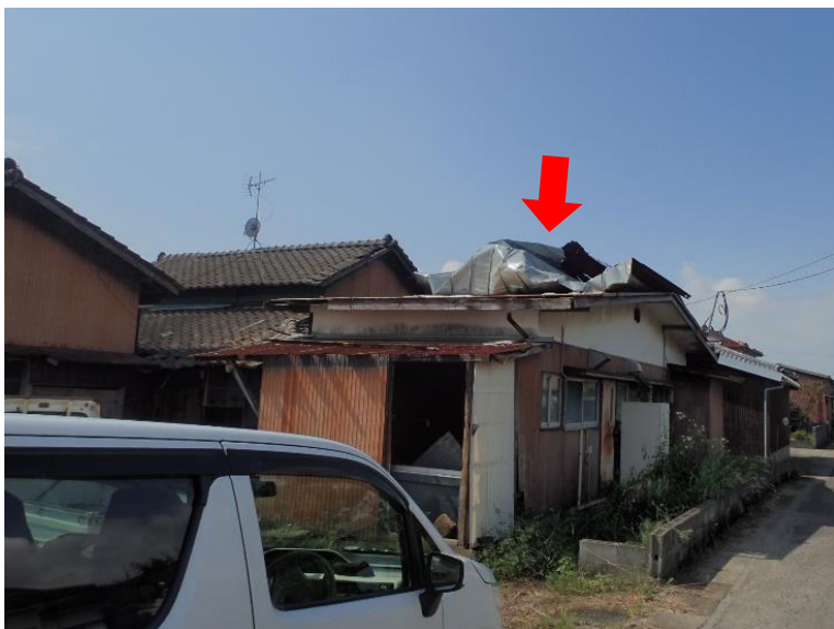
令和6年9月 施工前
