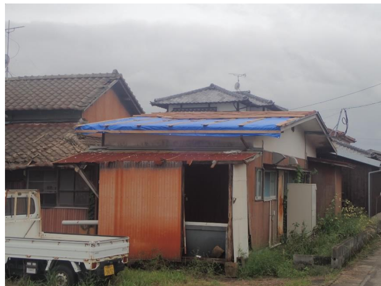
令和6年10月 施工後
