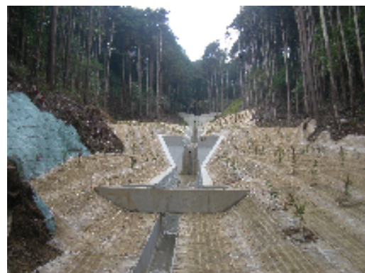
復旧治山事業の様子
