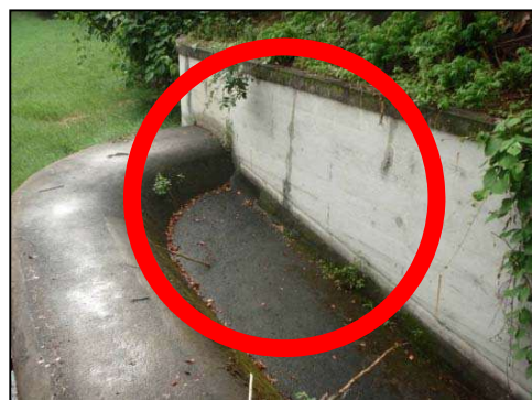
写真9：洪水吐流入部
