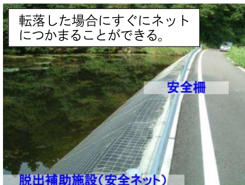
写真15：安全ネットの設置
