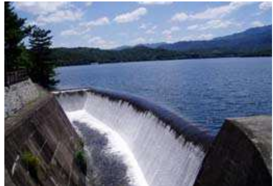
写真2：洪水吐 (香川県HPより)
