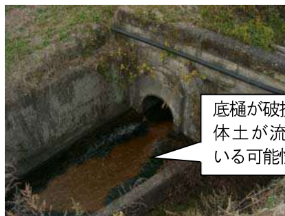
写真11：底樋出口（堤体下流）
