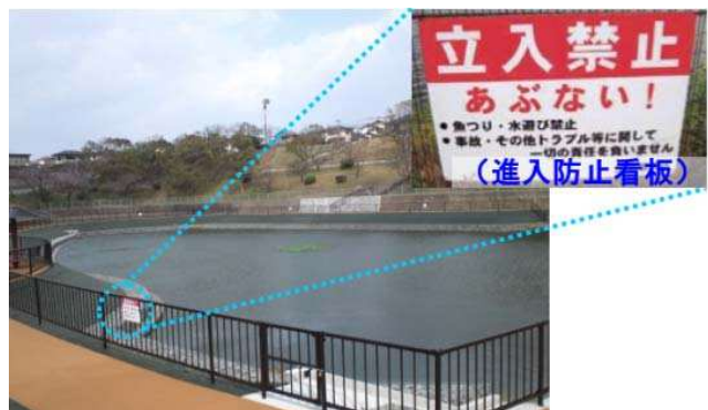
写真14：安全柵の設置
