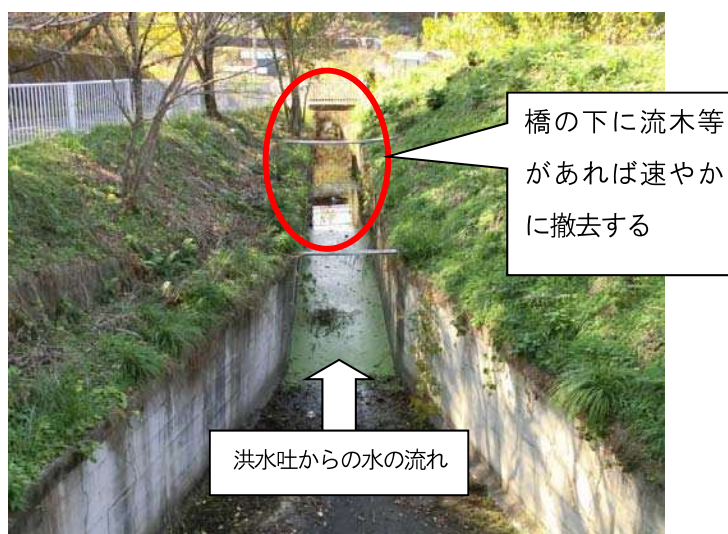
写真8：洪水吐下流水路の例
