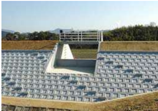
写真1：洪水吐 (香川県HPより)
