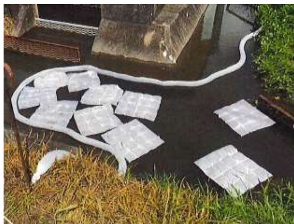
オイルフェンスとオイルマットの設置
