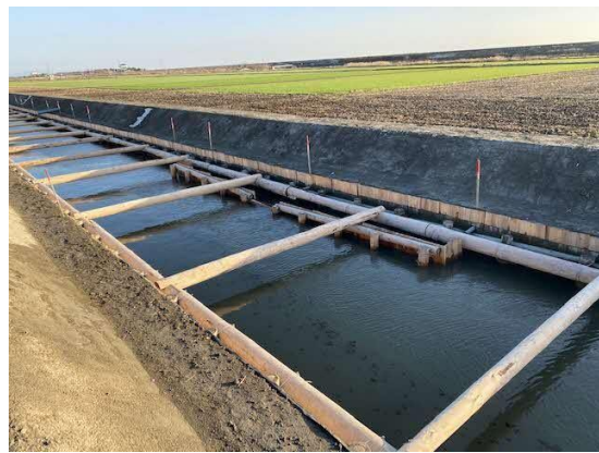
更新整備を行ったクリーク
