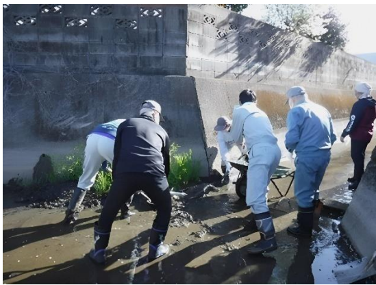
水路の泥土上げ
