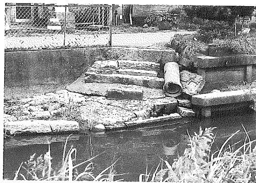
カワジ 家々では川（堀）に面して水使い場があった。水ぎわまで下りれるようになっていて、洗たく、米とぎ、茶わん洗いなどをした。(上新ヶ江)
