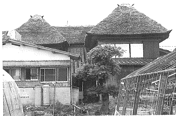
コ字型の屋根 棟をコ字型に曲げた屋根は、通称クド造りとも呼ばれる。棟が互いに支柱となって、台風に強い構造になっている。佐賀平野に広く分布している。(崩東 H13.10.20)
