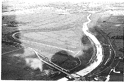
嘉瀬川改修 (ショートカット)
