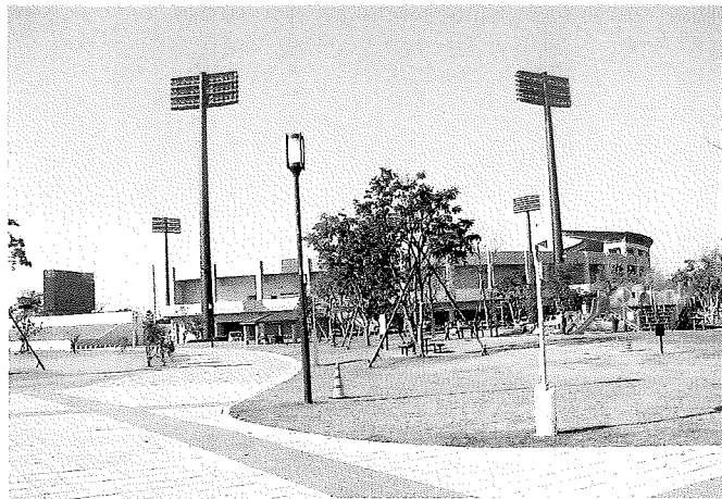
みどりの森県営球場 (平成11年3月完成)
