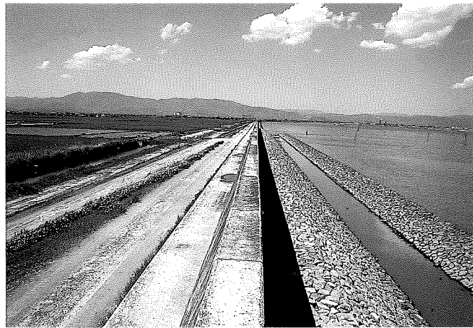
整備された海岸堤防
