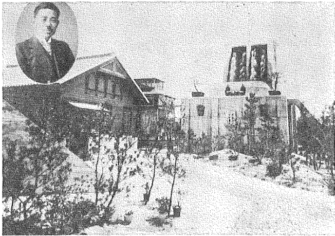
城内にあった佐賀市第四水源地の全景
