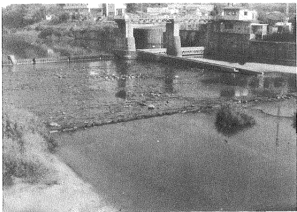
頭首工 (惣座橋より)
